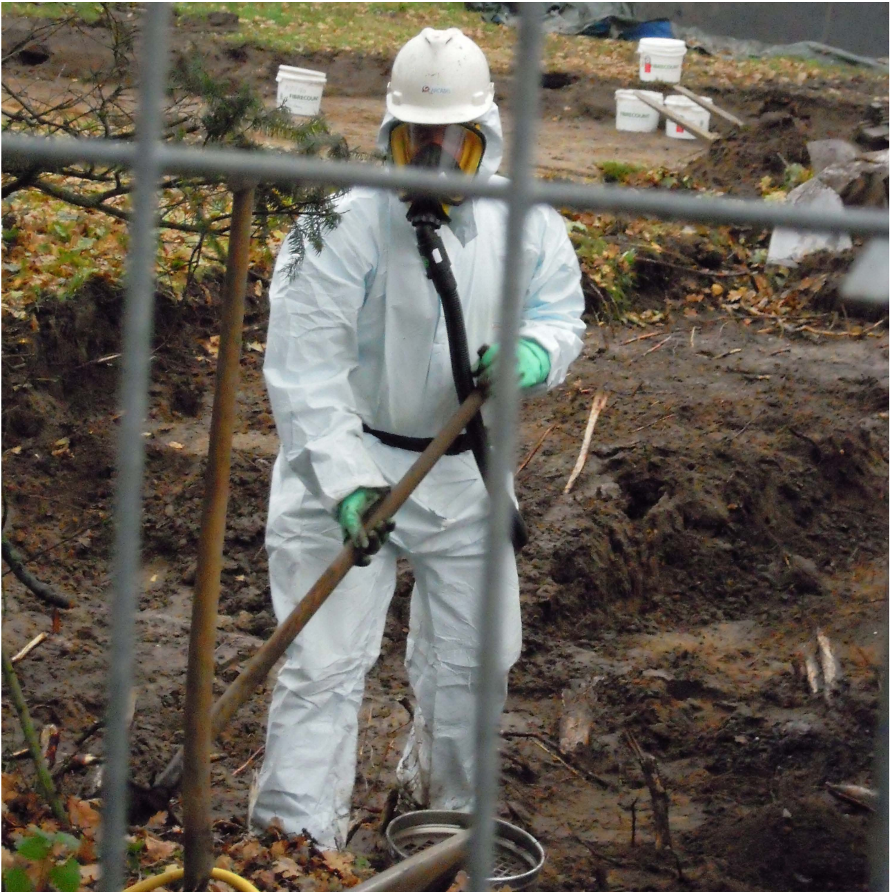
Asbestverwijdering
