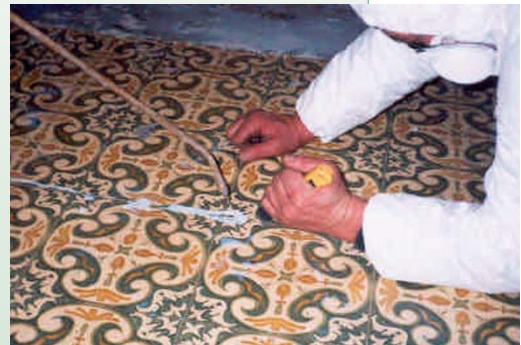
Asbesthoudende vinyltegels
