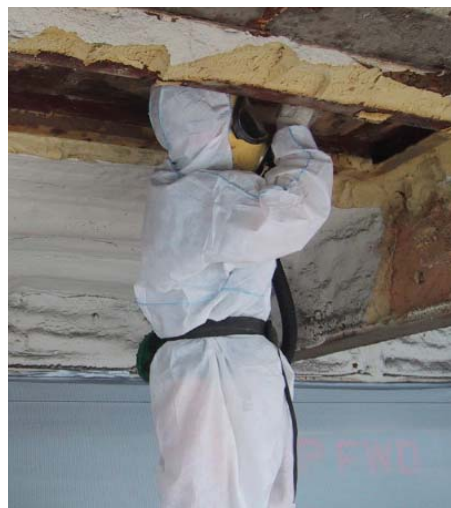
Het verwijderen van asbest na calamiteiten
