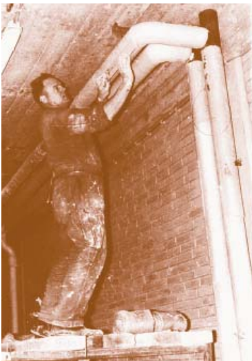
Asbest isolatiepijpen 'Balamundi' 1967 Bron: presentatie (P. Swuste: 26/1/2005)
