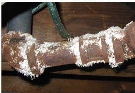
Asbestpijpsisolatie
