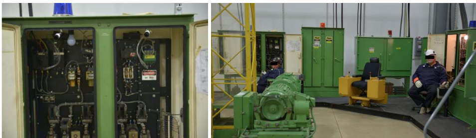
Figuur 4.2: Arc chutes waarin ingekapseld chrysotiel verwerkt was (bron: (M.J. McCoy 2021))
