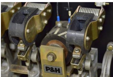
Figuur 4.2: Arc chutes waarin ingekapseld chrysotiel verwerkt was (bron: (M.J. McCoy 2021))
