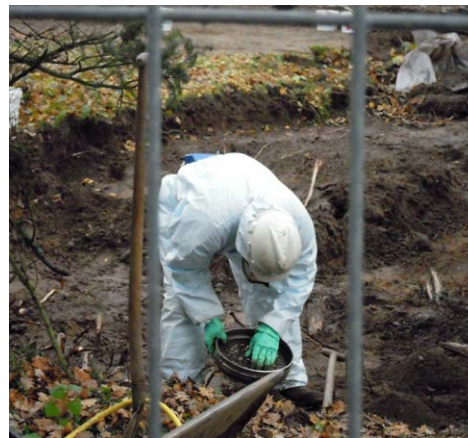
Asbest uit bodem verwijderen (Harderwijk, 2010)
