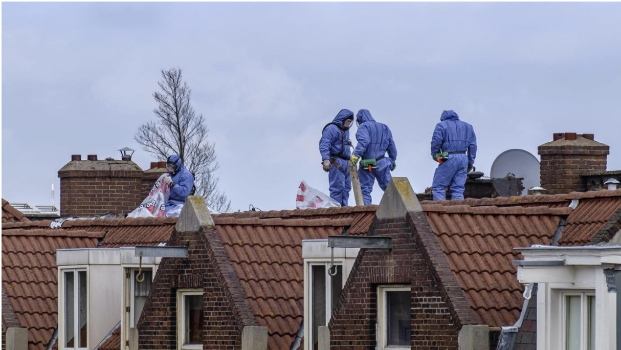
Verwijderen van asbest op daken in Amsterdam. Foto: Shutterstock
